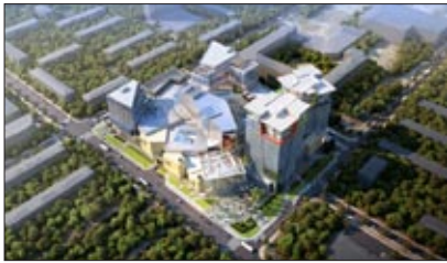
Kuntsevo Plaza in Moskau soll bis August 2014 fertiggestellt sein.
