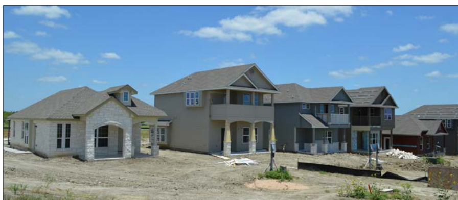
Der Flughafen Wien „rüstet nach“ (oben), Whisper Valley ist komplett energieneutral.
